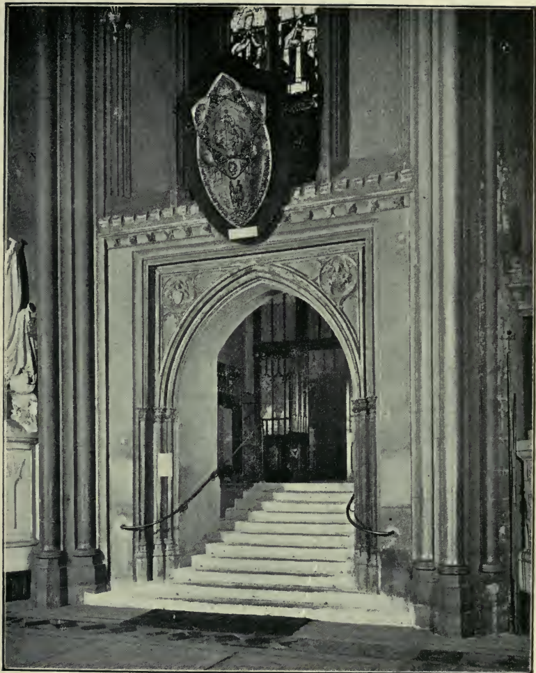
Photo. by the L. S. & P. Co., Ltd.
